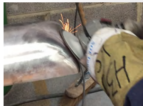
Usunięcie spoiny, wykończenie całej powierzchni
